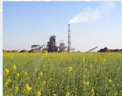
Biomassekraftwerk in Tonk, Indien.
